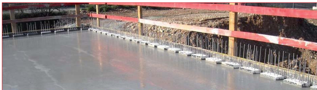
Rupteurs de ponts thermiques installés au niveau bas du dojo (crédit photographique : Ville de Saint-Laurent-du-Var)
