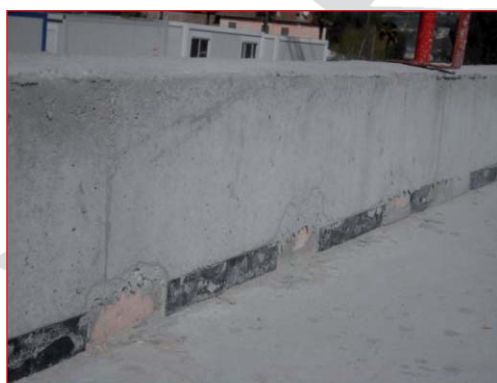
Rupteurs de ponts thermiques intégrés au bâtiment (crédit photographique : Ville de Saint-Laurent-du-Var)
